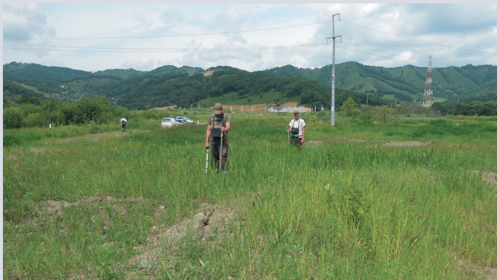
Рис. 3 Поиск дефектов антикор- розионного покрытия при помощи приборного комплекса ИП «Азимут»
